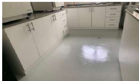
Ilustración 9: Área de laboratorio que presenta notables cambios en el acabado de la pintura epóxica.
