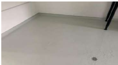
Ilustración 8: Se repararon las fallas de fisuras en el piso
